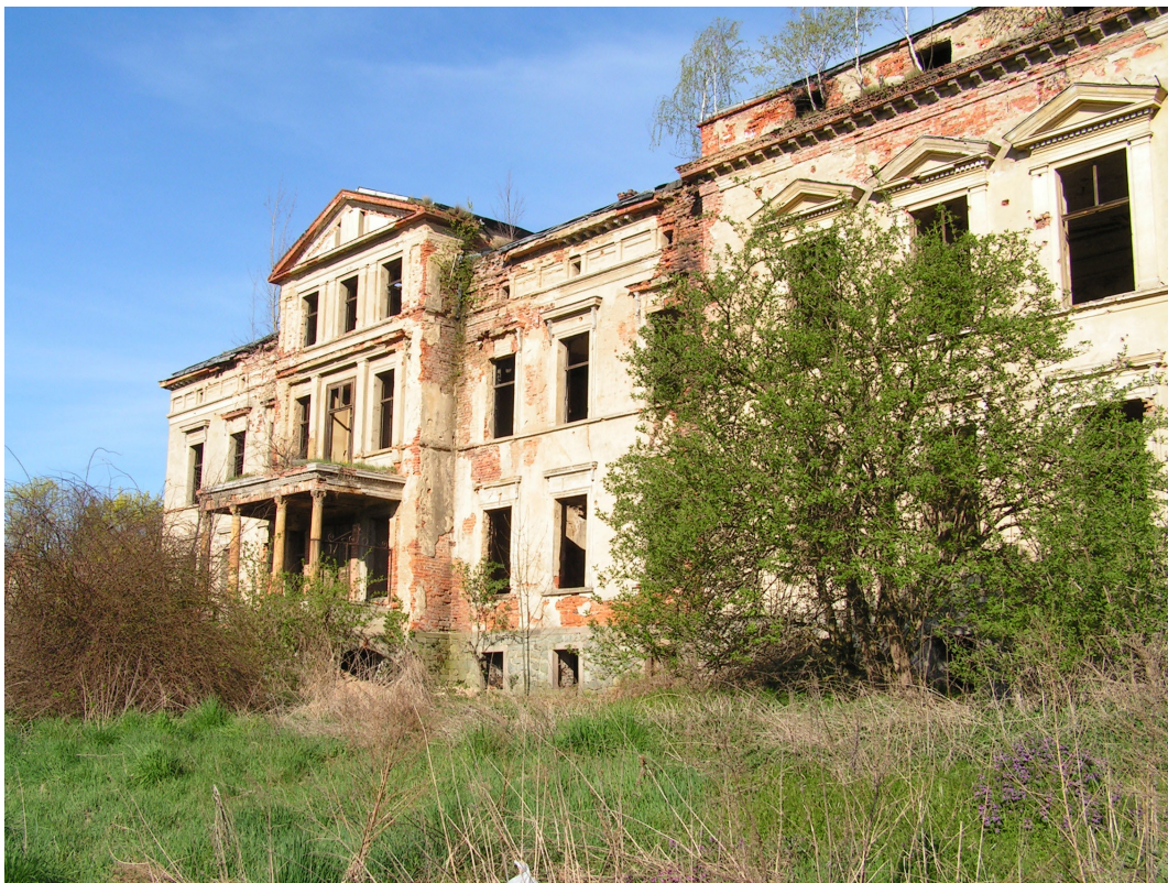
Fot. 30. Zniszczony i niezagospodarowany pałac w Piotrówku.
