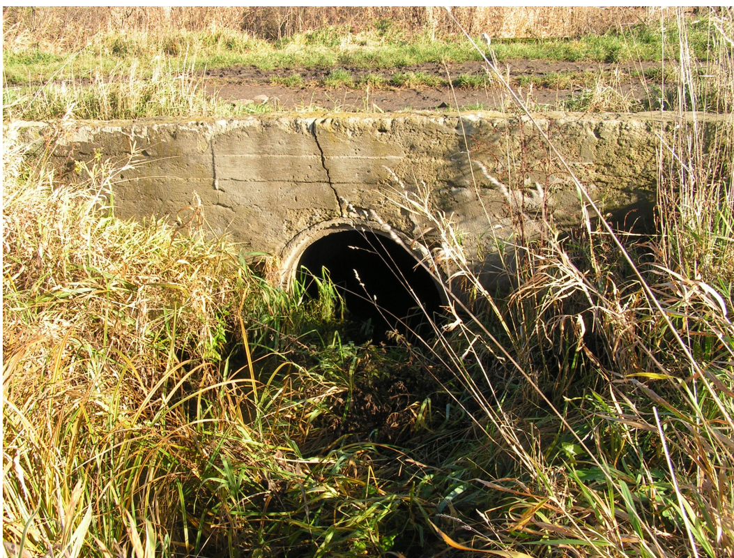
Fot. 19. Przykład przepustu w Jezierzycach Wielkich.
