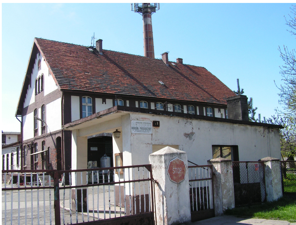
Fot. 29. Obiekty nieczynnej mleczarni w Jordanowie Śląskim.
