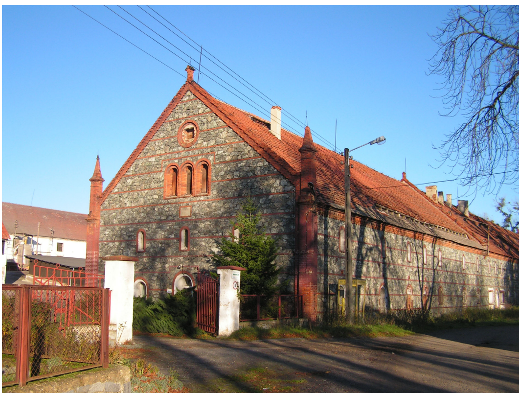
Fot. 8. Budynki w Winnej Górze przy założeniu pałacowym.
