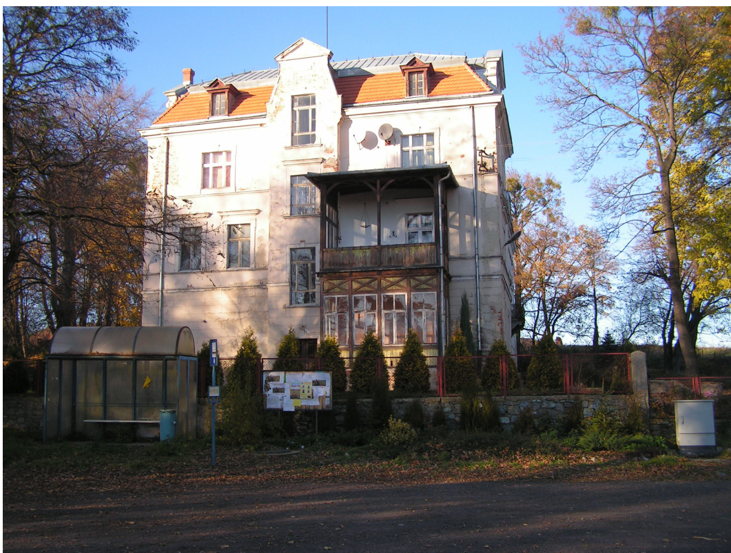
Fot. 31. Zabytkowy obiekt w Winnej Górze wymagający renowacji.
